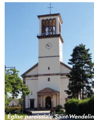
Église paroissiale Saint-Wendelin
