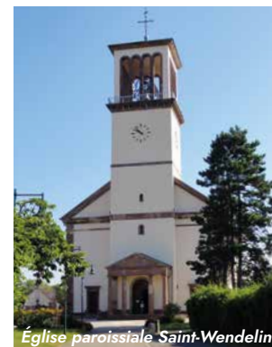
Église paroissiale Saint-Wendelin
